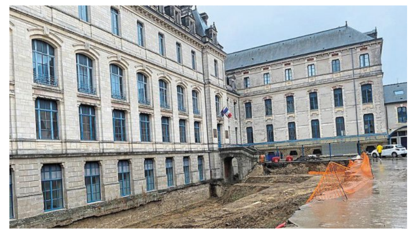
Des escaliers vont être construits devant l'établissement. Ils mèneront à un préau, puis à la cour arrière.
